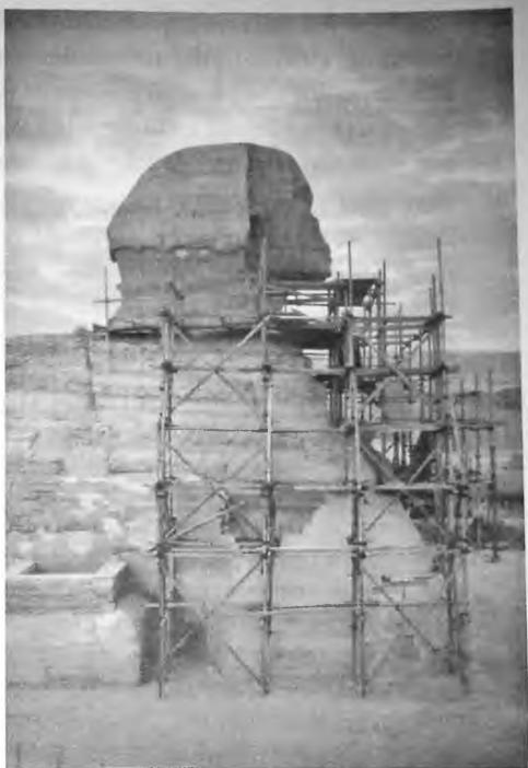
Ilustração 11-6. A Esfinge com o toucado plano. Os andaimes mostram a ocorrência de uma reconstrução ou estabilização.
